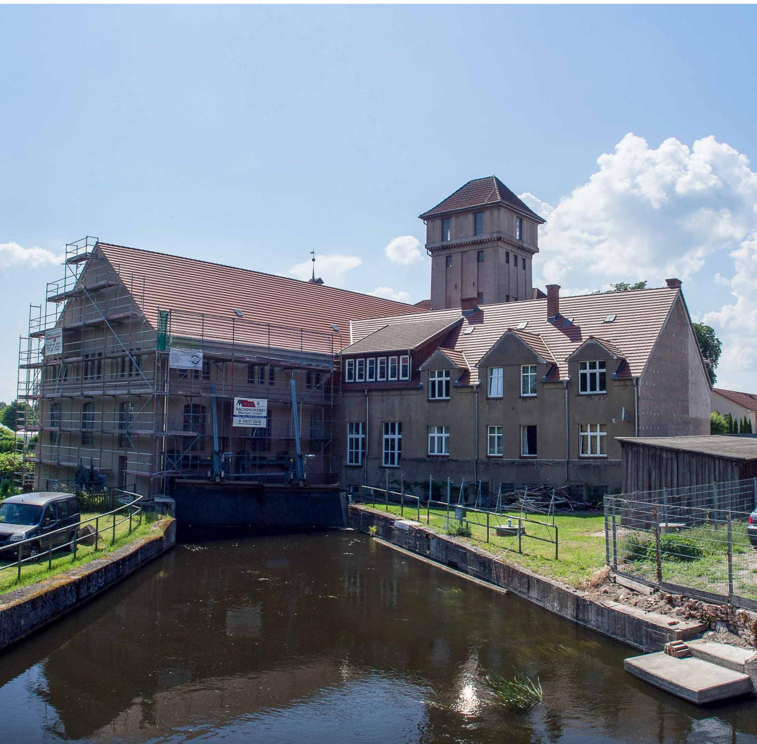
Das Elektrizitätswerk in der mecklenburgischen Stadt Neustadt-Glewe ist ein Laufwasserkraftwerk an einem rechten Seitenarm des Flusses Elde. Bis in die 1980er Jahre dienten zusätzlich Dieselaggregate der Stromgewinnung. Das Elektrizitätswerk mit Maschinenhaus, Verwaltungsgebäude und Fachwerkschuppen steht unter Denkmalschutz.
