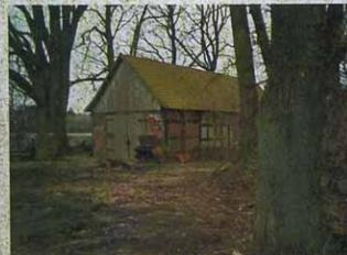
Die Sicherung des Gebäudes erfolgte in dem ersten Schritt durch eine Teilsanierung der Holzelemente, ein Überhang wurde abgerissen und das Dach mit gebrauchten, allerdings jetzt intakten Pfannen neu eingedeckt. Das Innere des Stalles wurde entrümpelt und neue Türen eingebaut.
